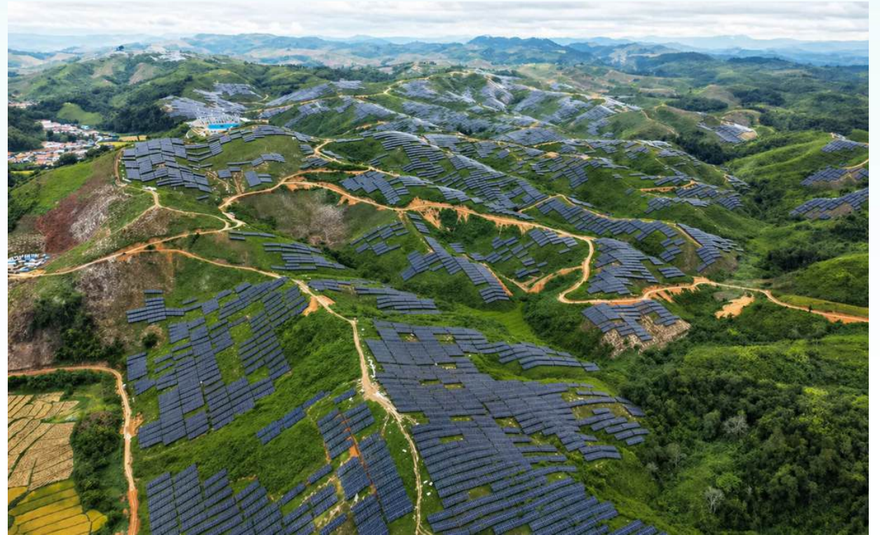
Trang trại điện mặt trời vùng núi tại Lào. Ảnh: CMG
