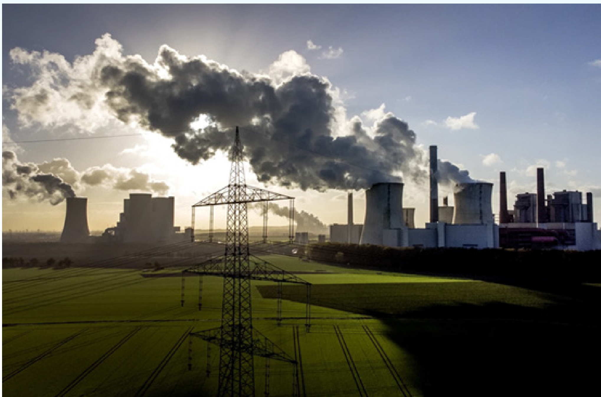
Hơi nước bốc lên từ nhà máy điện than Neurath, gần Grevenbroich, Đức, ngày 2/11/2022. Ảnh: Tạp chí điện tử Hiệp hội năng lượng sạch Việt Nam
