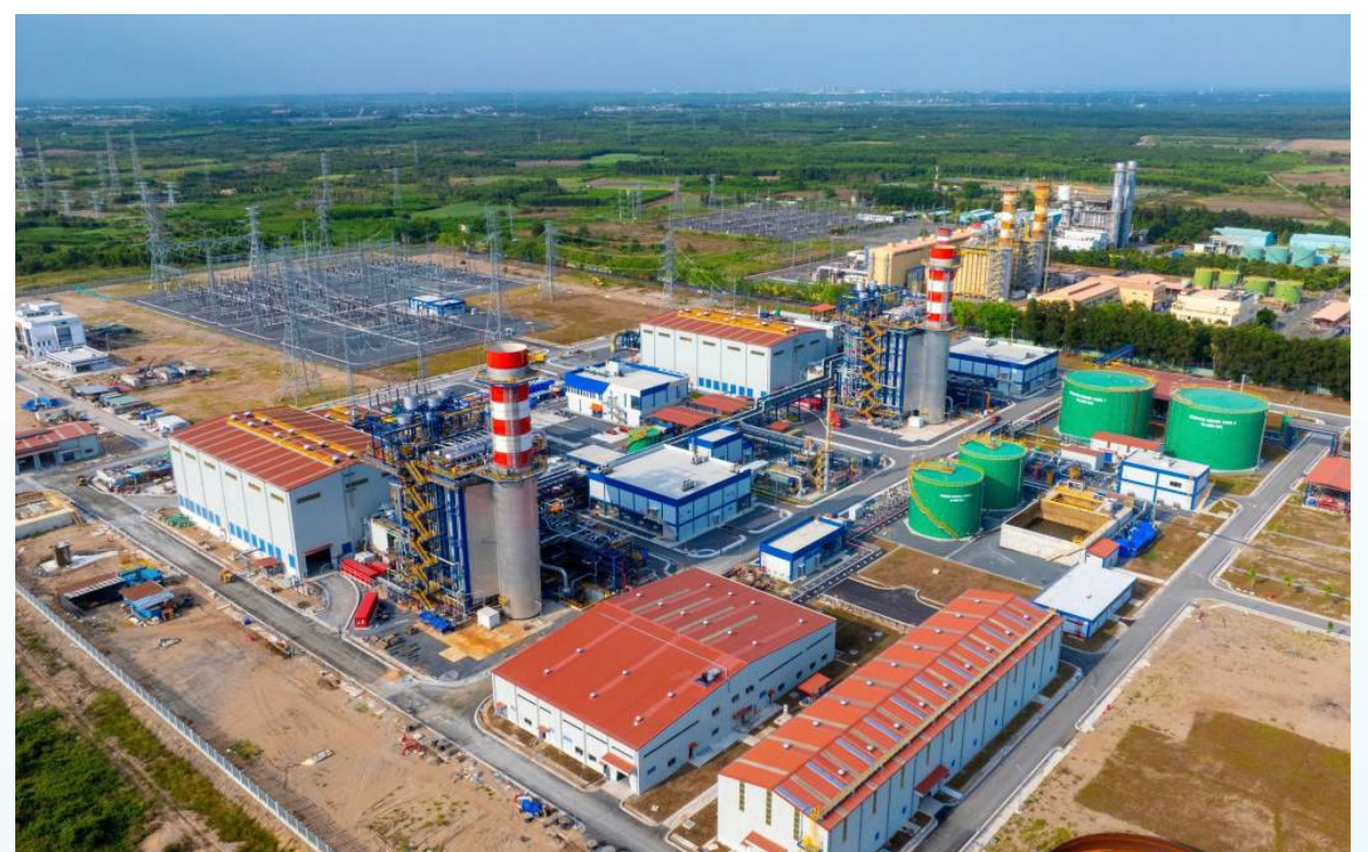
Dự án tiên phong của điện khí LNG tại Việt Nam, Nhà máy nhiệt điện Nhơn Trạch 3 và 4. Ảnh: vov1.vov.vn.
